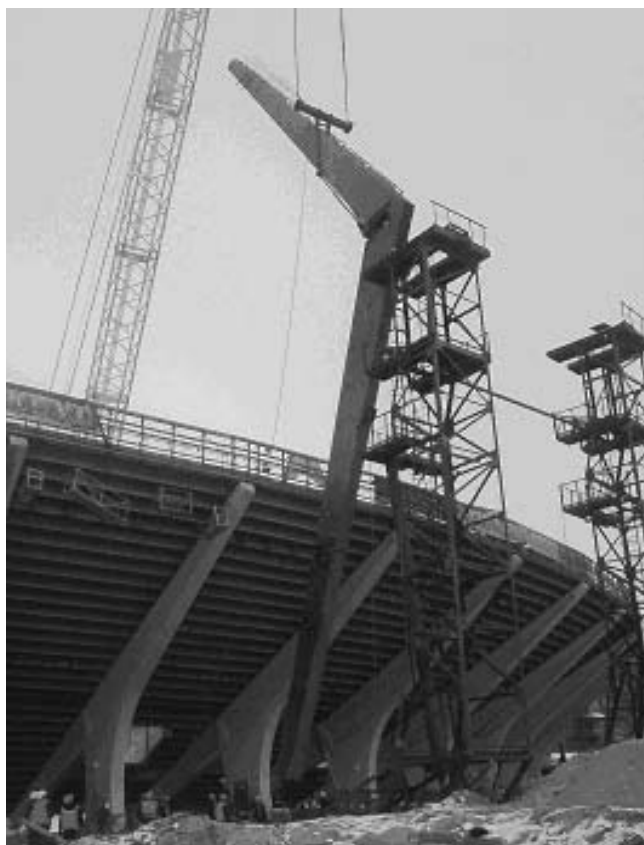
Рисунок 9. Загальний вигляд монтажу колони
