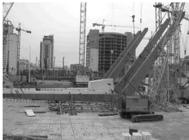
Рисунок 8. Загальний вигляд розміщення колон на стенді
