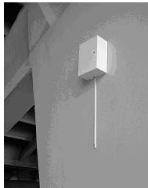
Рисунок 4. Датчик ВКВ-2 на опорі другого ярусу трибун
